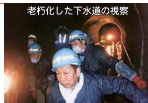
老朽化した下水道の視察
